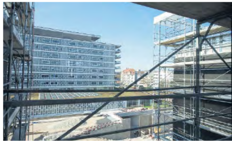
Der «Altbau» vom Neubau aus gesehen.
