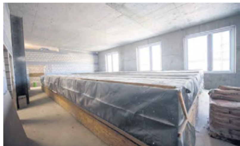
Hier im Parterre entsteht das Therapie-Schwimmbecken.
