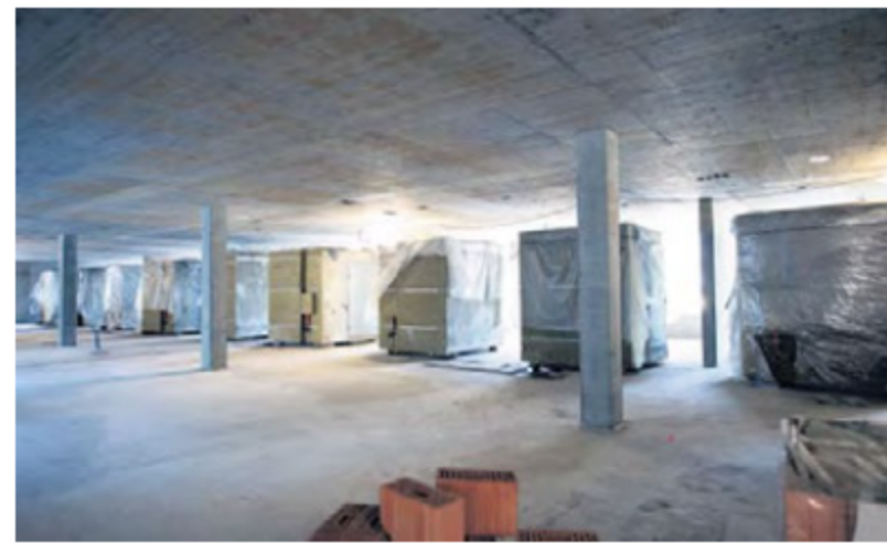
Die Nasszellen-Elemente stehen bereit zur Installation.
